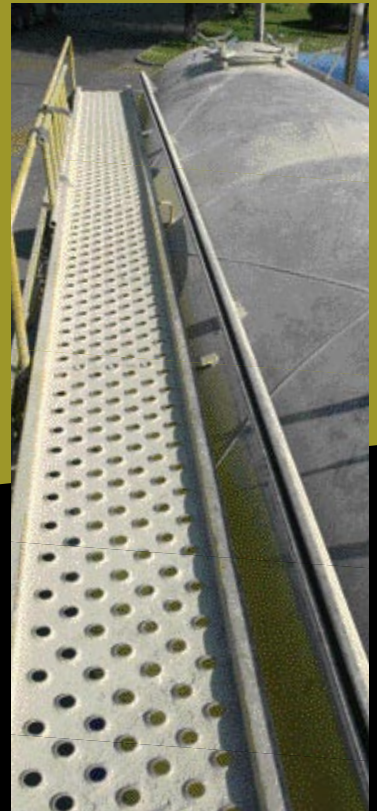
Pasarela de inspección con riel para gancho de seguridad.
